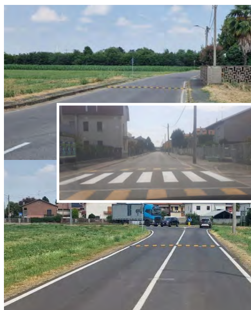
Lavori eseguiti in Viale Padania
